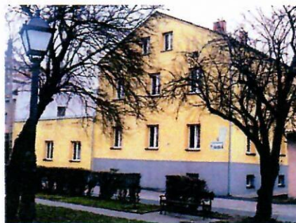
Fot. 5. Mała Synagoga, ob. budynek mieszkalny, ul. Kaliska 8 (karta adresowa Gminnej Ewidencji Zabytków).
